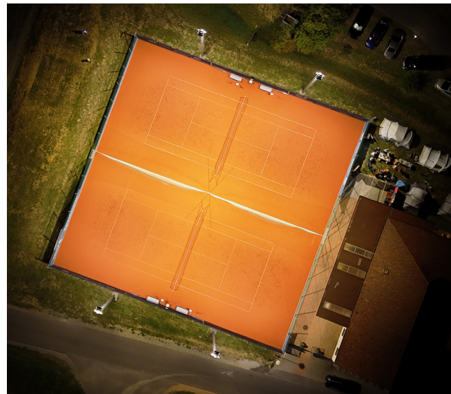
Neue Flutlichtanlage im Einsatz
